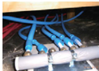
将来の配管交換が容易な給水さや管ヘッダー工法
