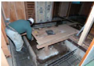
新設基礎と基礎補強で鉄筋入り基礎に
