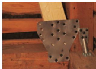
耐震金物補強
