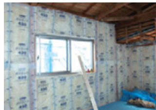
すべての床、壁、2階天井に断熱材
