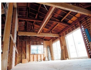
施工中／構造躯体まで解体した状態
